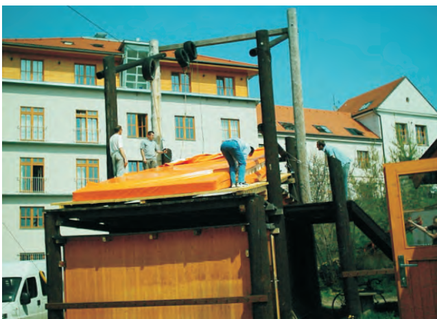
Dopadová plocha při dojezdu na lanové dráze v Praze Vysočanech
